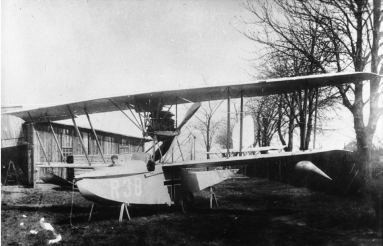
Hinter der in Wien-Floridsdorf eingelagerten Lohner Type R (Werknummer R38) verbirgt sich die wenig später zum Passagierflugzeug umgebaute Lohner Type R (Schweiz) CH 62. Das von der Lohnerwerke GmbH gefertigte Exemplar gelangte durch das Kriegsende bedingt nicht mehr zur Ablieferung an die Kriegsmarine der Doppelmonarchie. Zu diesem Zeitpunkt ist das Flugboot noch mit einem 185 PS starken Austro-Daimler Triebwerk ausgerüstet.
